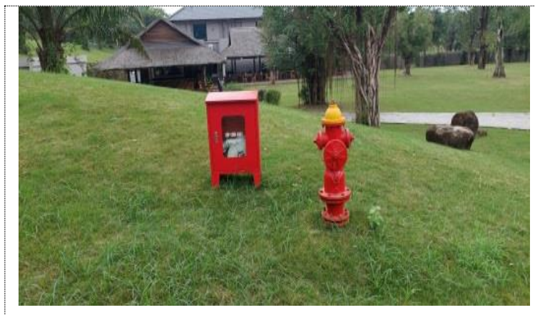
Hình 1. 7. Các họng cứu hỏa được bố trí trong Dự án
