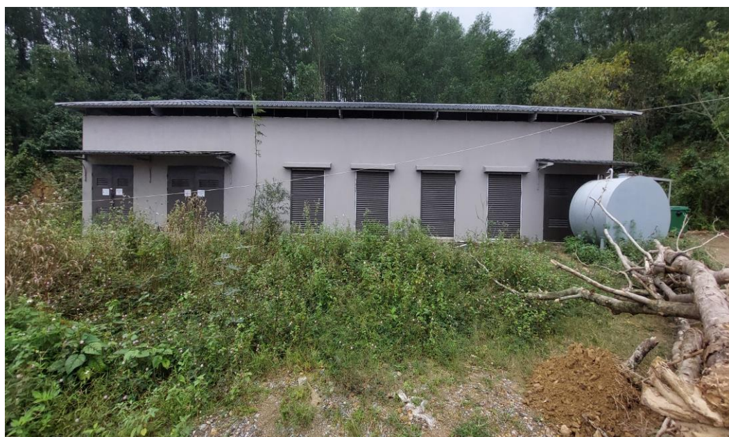
Hình 1. 4. Trạm biến áp của khu Nghỉ dưỡng
