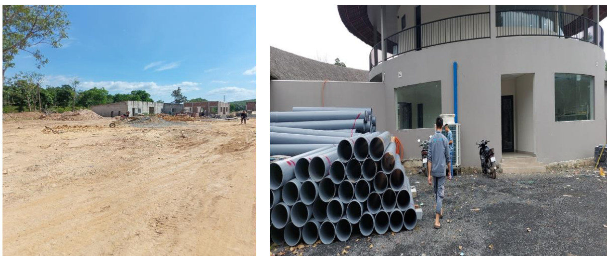
Hình 1. 8. Hình ảnh trong quá trình thi công xây dựng
