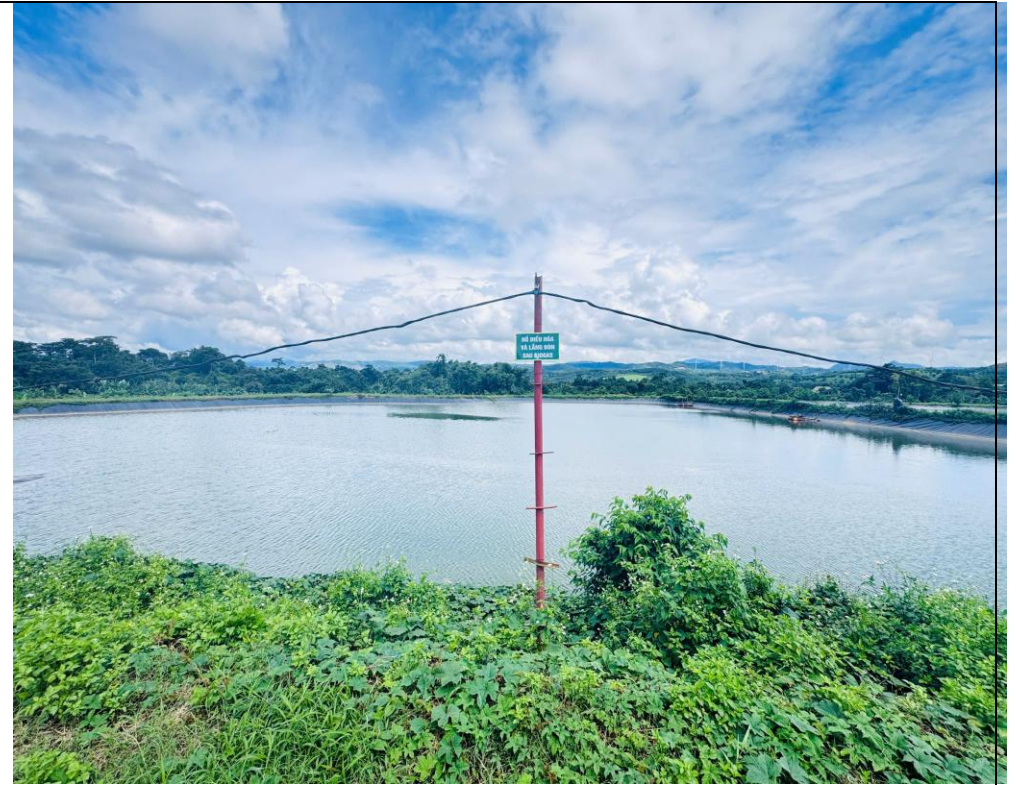
Hồ chứa sau biogas V=84.000 \text{ m}^3
