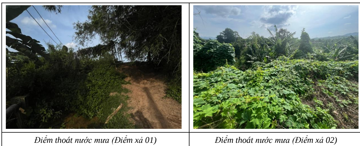
Hình 3.2. Một số hình ảnh về hệ thống thu gom, thoát nước mưa của Nhà máy
