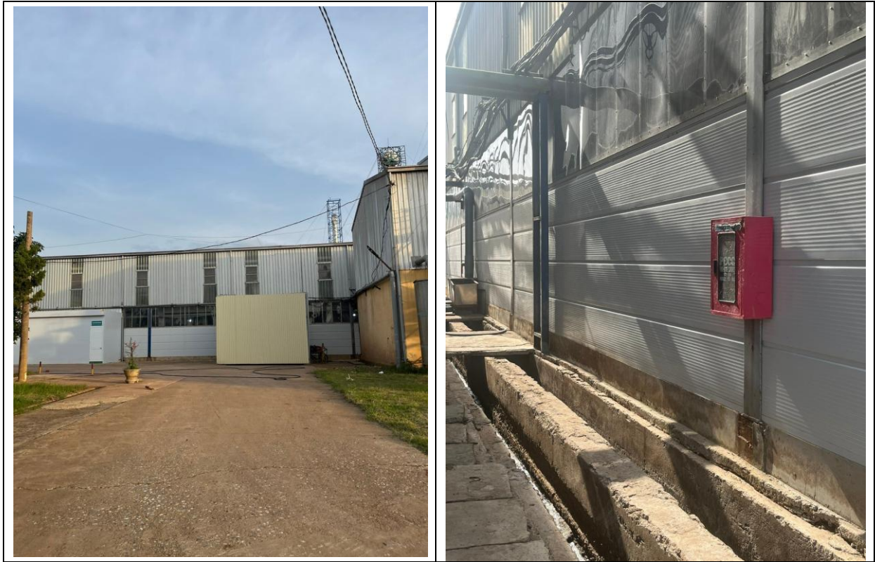
Hình 3.5. Một số hình ảnh hệ thống thu gom nước thải sản xuất
