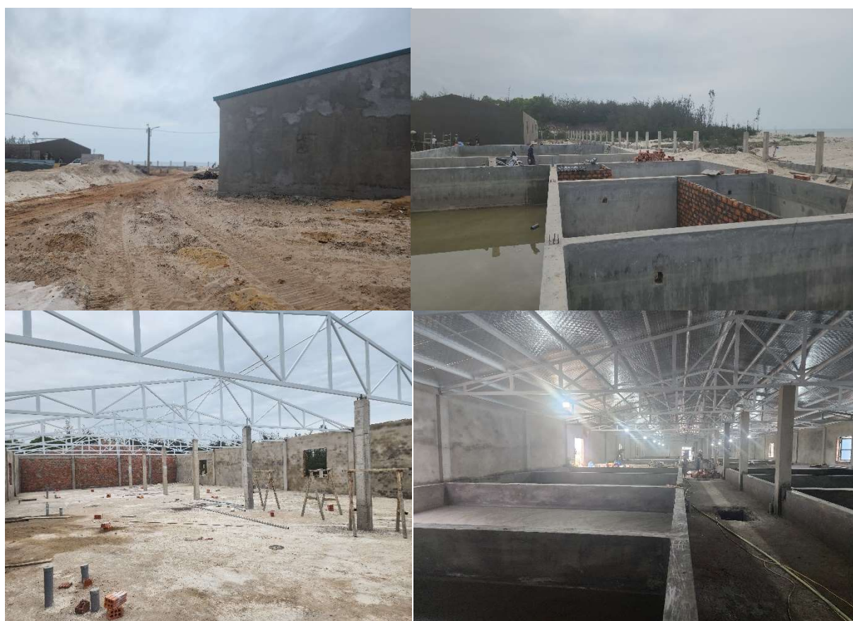
Hình 1.2. Hình ảnh đang thi công hoàn thiện mặt bằng và nhà nuôi ốc Hương
